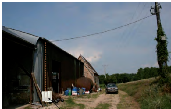
Le local technique pourra être prévu au plus près du point de raccordement au réseau.
