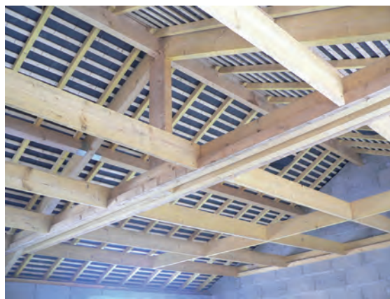
Charpente en bon état. © Nicolas Février - Fotolia.com
