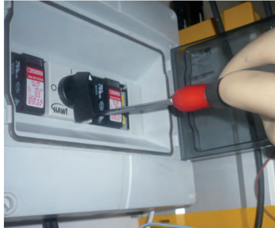
Intervention sur un coffret électrique.
