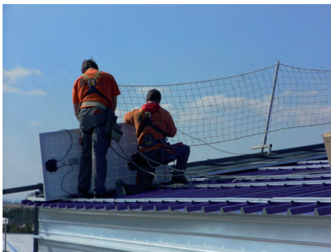
Exemple de chantier avec filets de protection collective et EPI. © Française Solaire
