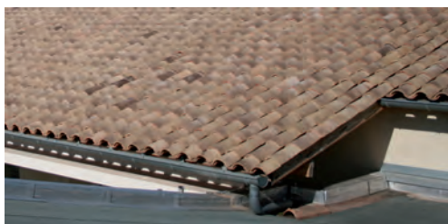
Attention aux points singuliers qui gênent l'implantation des modules.
